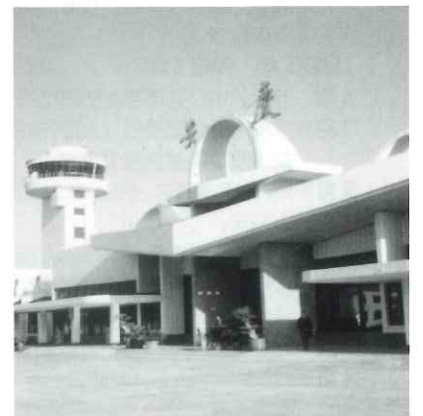
安慶空港 Anqing Airport 安庆机场
